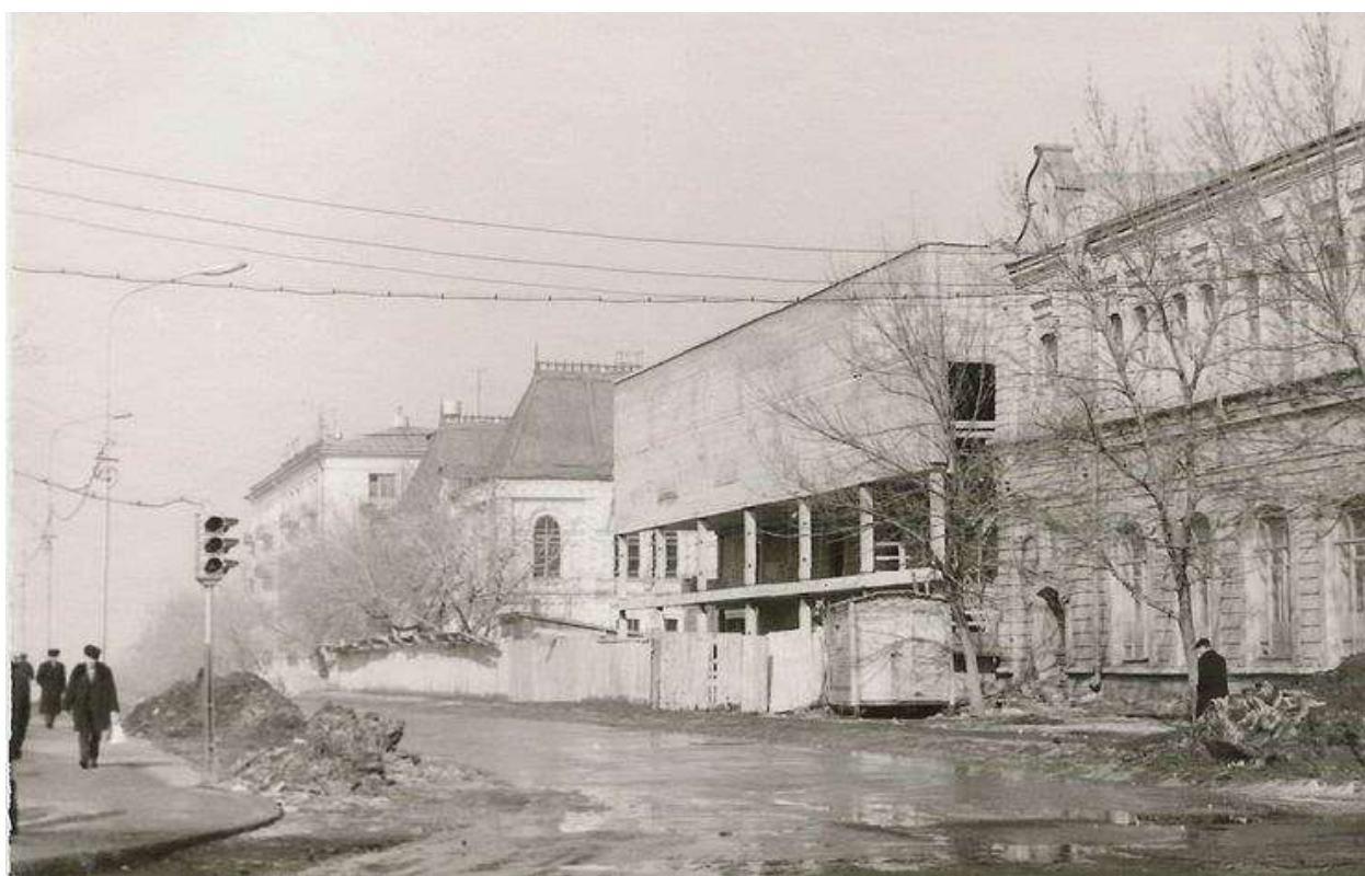
Строительство Дома актера, 1968
